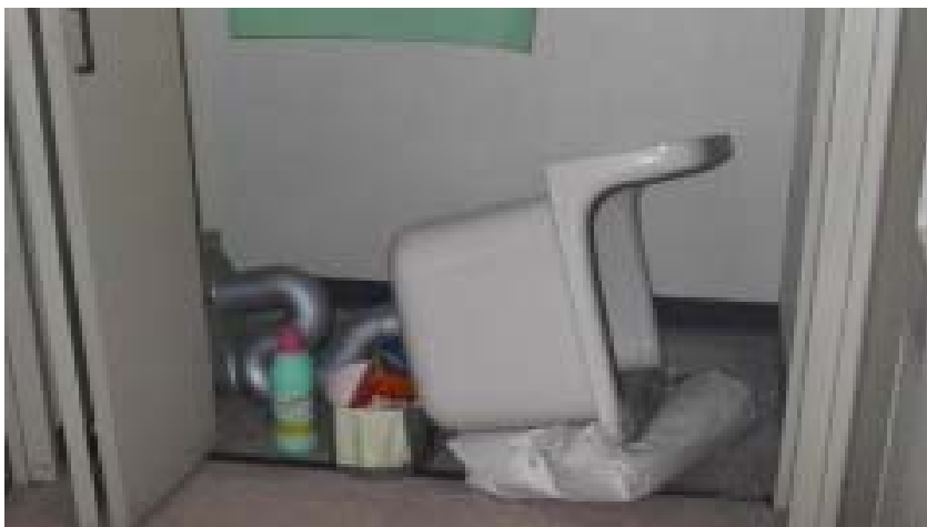
写真 3.2.12 掃除用流しの転倒
