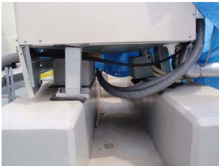
写真 2.2.6 家庭用ヒートポンプ給湯機用タンク脚部の仮復旧
