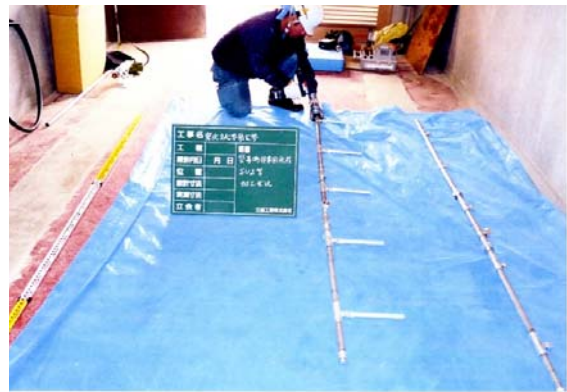
写真 5.2.1 給水栓ユニット接続部詳細
