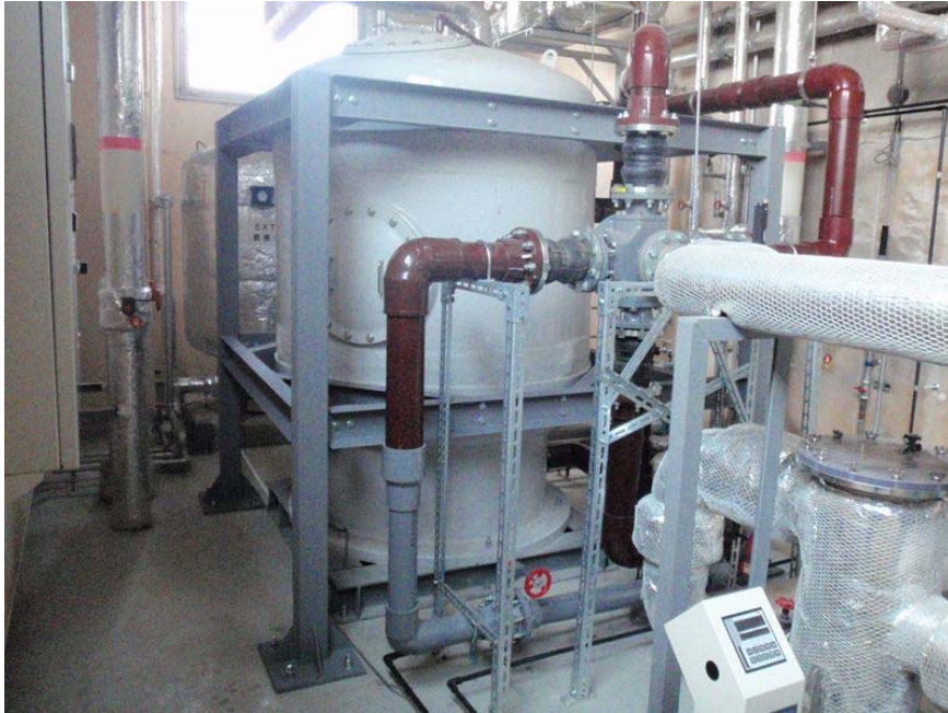
写真 3.2.17 砂式ろ過器の基礎を撤去して、鋼製架台に変更
