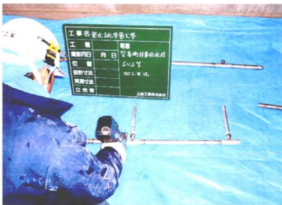
写真 5.2.2 給水栓ユニット組み立て状況
